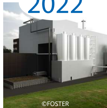
Erfolgreicher Wiedereintritt in den Markt für die thermische Klärschlammbehandlung durch den Gewinn des Auftrags zur Lieferung der neuen Anlage in Flandern, Belgien
