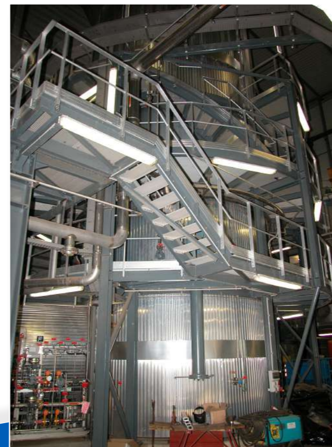
Stationärer Wirbelschichtofen für die Verbrennung von kommunalem Klärschlamm (KSAV Pierre Benite, Frankreich)
