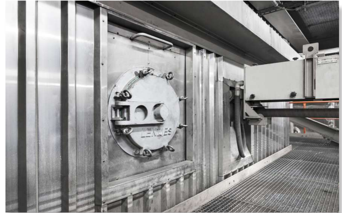
Kessel mit zirkulierender Wirbelschicht, eingesetzt in einem Kraftwerk in Berlin
