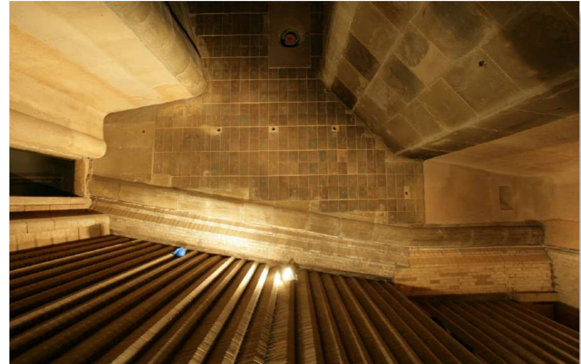
Vorschubrost, eingesetzt für die thermische Behandlung von Siedlungsabfällen im MHKW Frankfurt am Main
