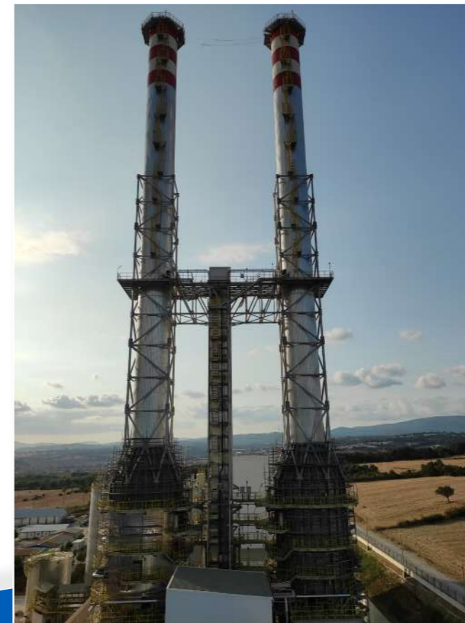
Anlage zur Entschwefelung der Rauchgase mit nassem Kalkstein, installiert in einem Kraftwerk in Can, Türkei
